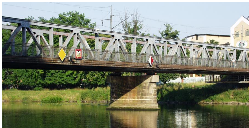
Obr.1 Pohled na konstrukci
